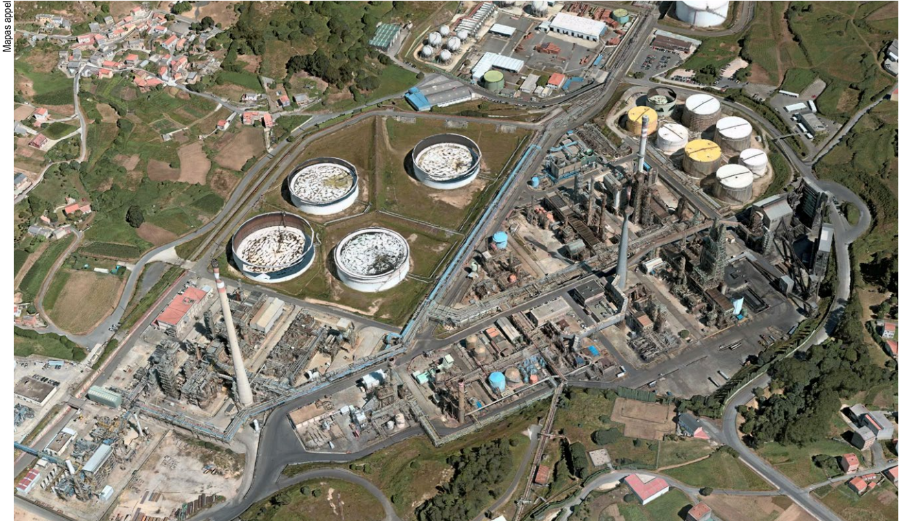
Air Liquid Ibérica na Coruña.
