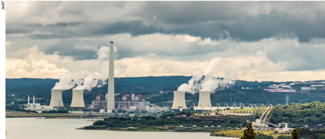
Central térmica sita nas Pontes.
