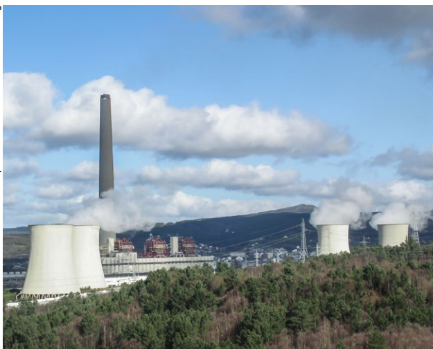
Central térmica das Pontes.
