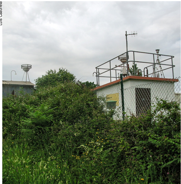
Estación de control de contaminación atmosférica de Alcoa.
