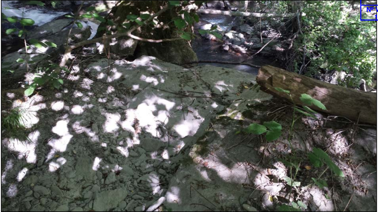
Fotografía 2: Vista del material sedimentado en zonas de paso de agua no permanente en el cauce.
