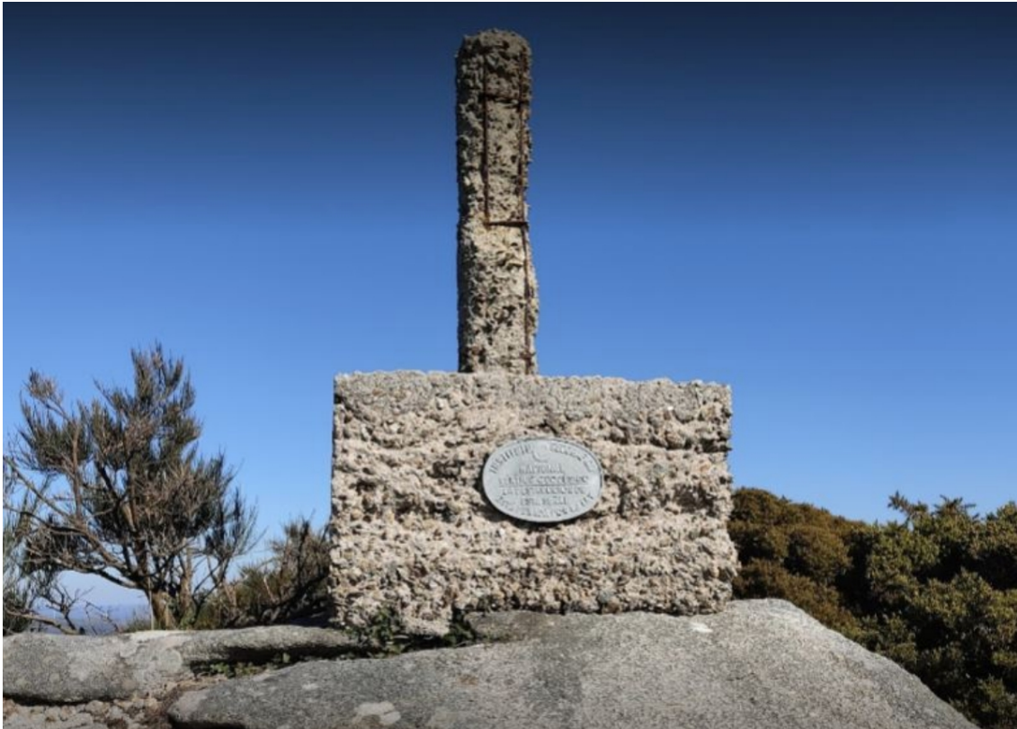
Fig 3. Aspecto do actual vértice xeodésico situado no alto da Ruña, totalmente destruído polo efecto das xeadas invernaís.
