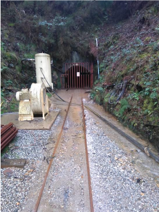
Foto 13 – Boca de acceso ás galerías do nivel 4 de Buenaventura.
