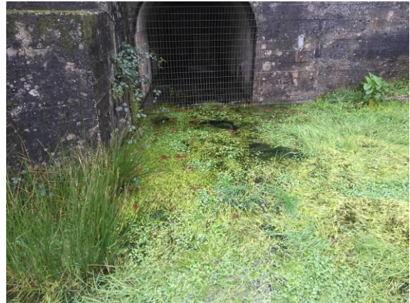
Foto 20 – Detalle das augas que afloran da galería de Castiñeiros 2. Procédese á toma de mostra M-DC-JPR-080216-A3 (V-17945)
