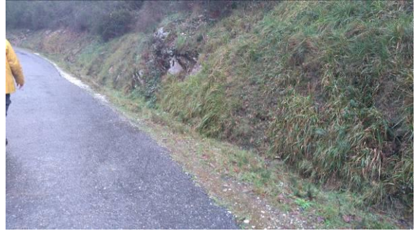
Foto 8 – Vista da cuneta pola que se canalizaran as augas de achique
