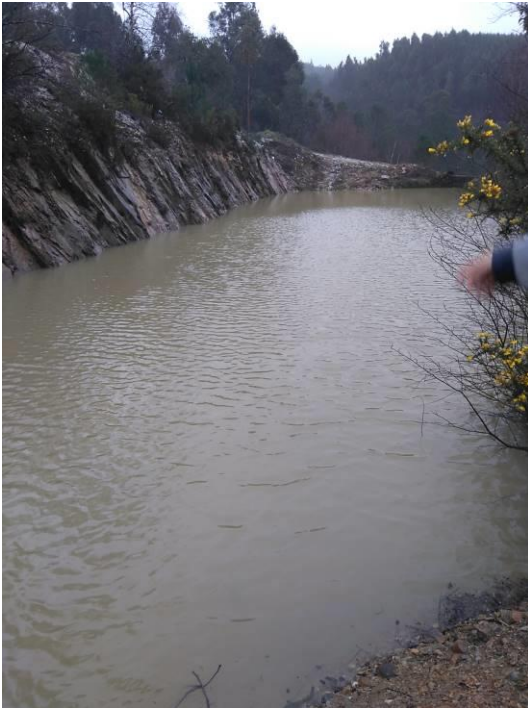
Foto 11 – Balsa excavada que actualmente recolle parte das escorrentas da zona situada augas arriba. Sobre os 2/3 desta balsa executarase a cama de caliza, quedando o 1/3 restante como balsa de seguridade da pranta.
