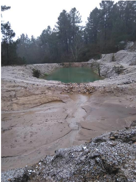
Foto 15 – Detalle da balsa final escavada no terreo. Actualmente atópase dividida en dous compartimentos, e prevese a súa división en 3 para favorecer a realización das labores de limpeza e mantemento
