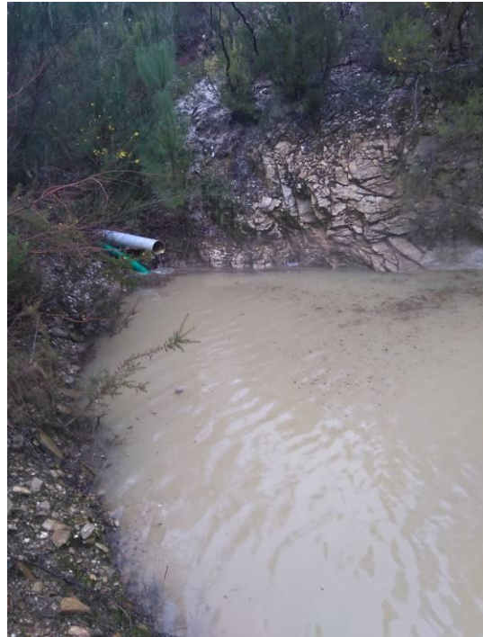
Foto 12 – Detalle da entrada á balsa da foto 11. Actualmente atópanse conducidas ata aquí parte das escorrentas da zona.
