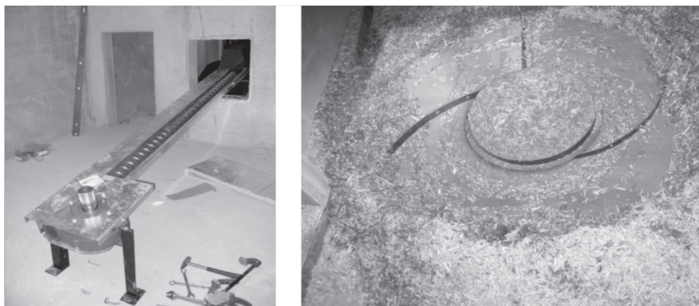
Figura 4. Sistema de alimentación da caldeira (esquerda:montaxe; dereita: en funcionamento).
