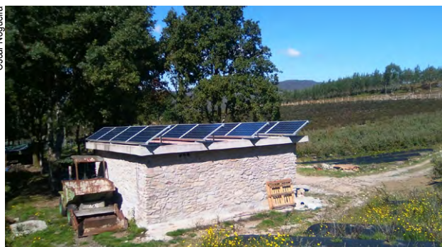
Instalación fotovoltaica illada para bombeo nunha finca de produción de arandos ecolóxicos en Cotobade.
