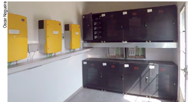
Baterías de nova xeración de ión litio en instalación fotovoltaica illada en Santiago de Compostela.
