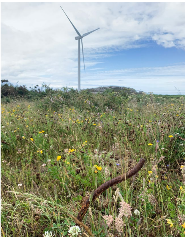
Parque eólico de Corme · O Fins
