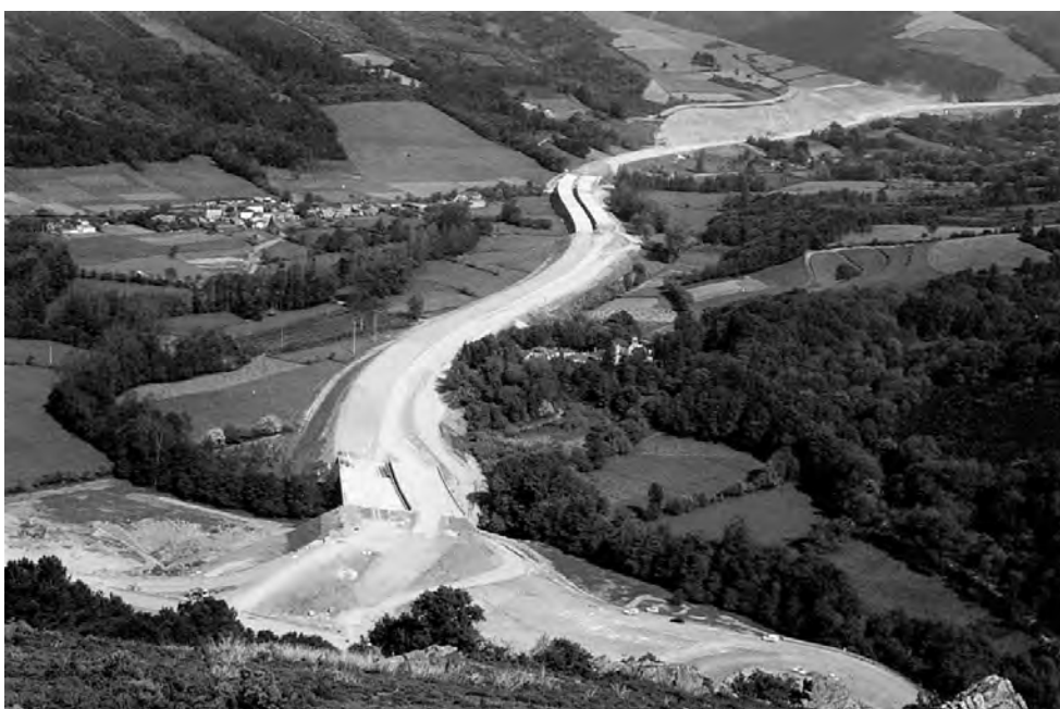
Figura 1.4. Obras na autovía do Noroeste ao seu paso polo val do río Neira.
