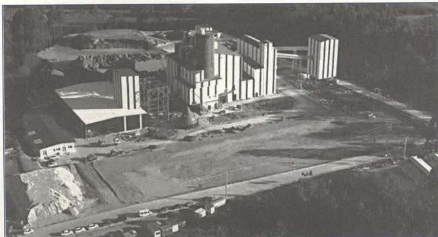
A cementeira ocasiona un continuo trasego de camións, ruído no moído de materiais e pó.
