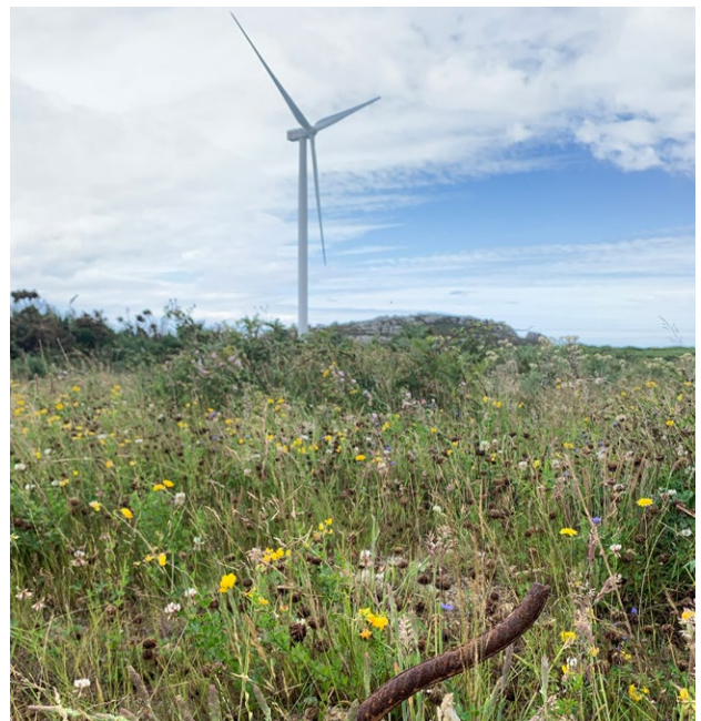
Parque eólico de Corme · O 'Fins
