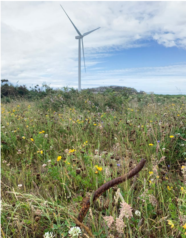
Parque eólico de Corme · O Fins
