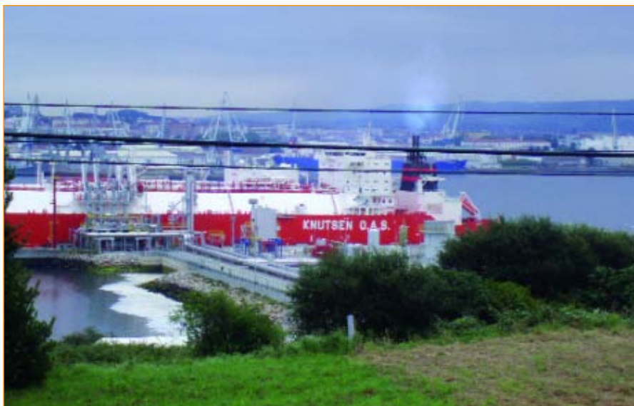
Proceso de regasificación do Gas Natural Licuado (GNL): o gas viaxa nos barcos en estado líquido a unha temperatura de 169°C baixo cero, polo que precisa ser queentado para regasificalo
