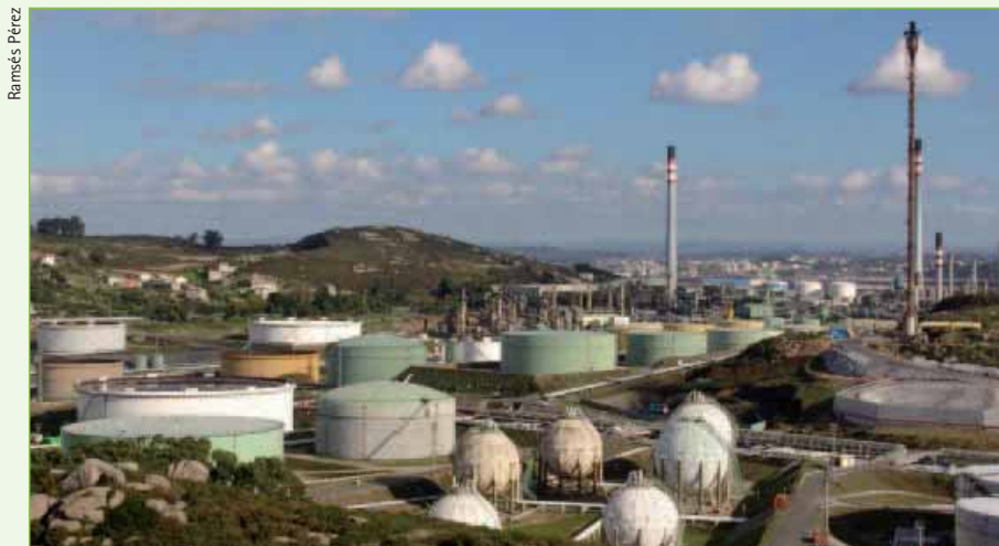
Repsol YPF na Coruña.
