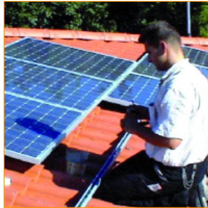
Instalación de módulos fotovoltaicos no tellado dunha vivenda (pola empresa Isofotón)
