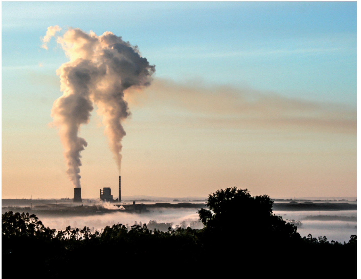
Central térmica de Meirama
